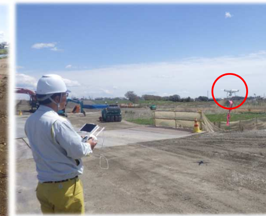
自動追尾による測量やドローンによる撮影
