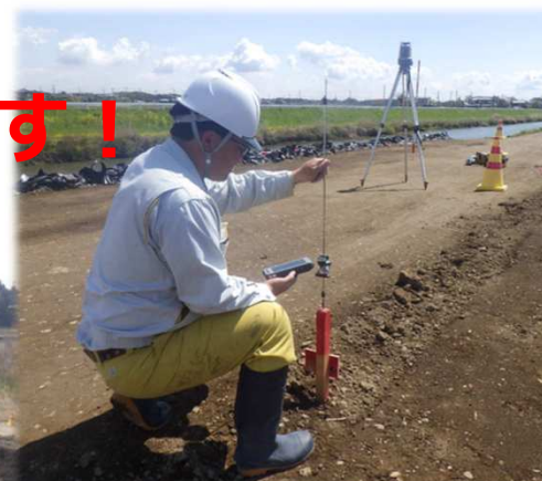
自動追尾による測量やドローンによる撮影
