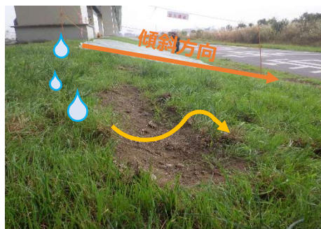
↑ 植生がめくれ土砂が洗堀されている状態
