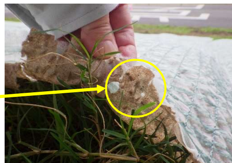
↑ 植生がめくれ土砂が洗堀されている状態
