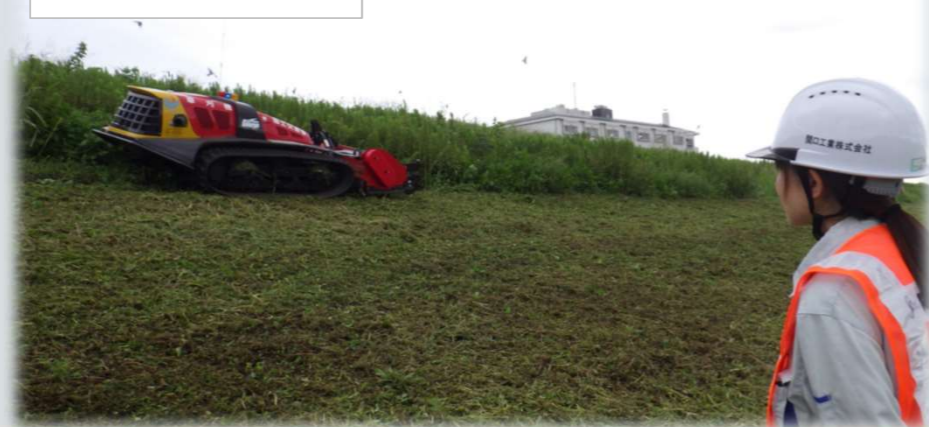
作業状況(遠隔操縦式)
