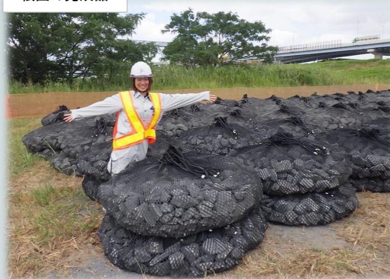
根固め完成品
