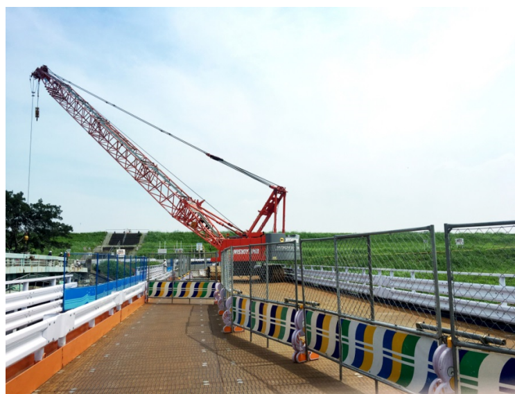
他作業確認写真
