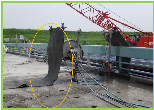
↑ワイヤーソーのワイヤーが切れて近くにいる人が事故に起きないようにカバーをしていました。
